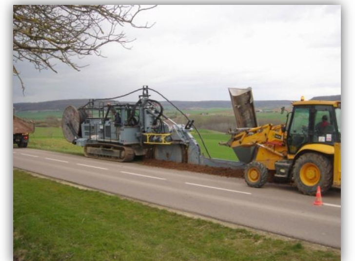
Réalisation de la tranchée (photo exemple)
