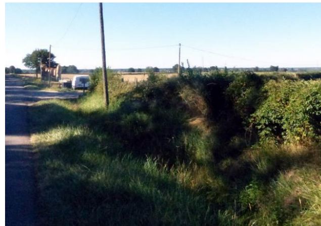
Fossé en bordure Est de la zone d'étude le long de la RD37 à gauche (MICA Environnement)
